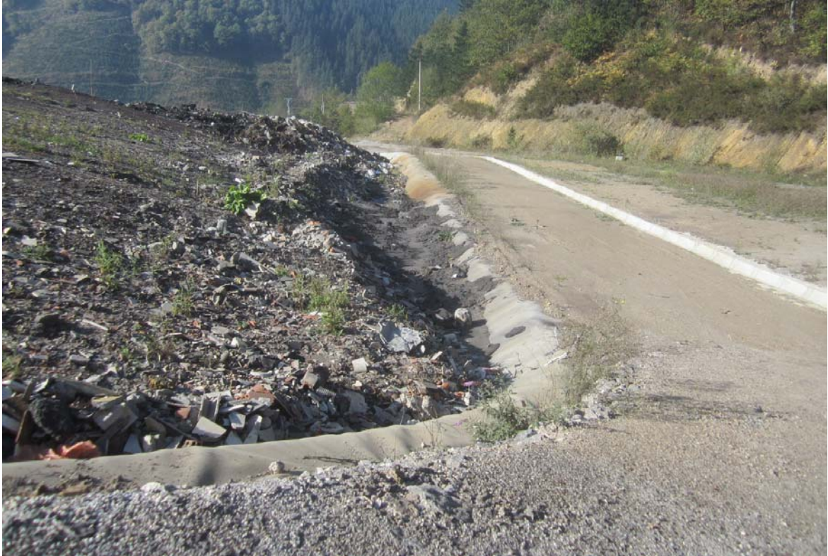
Fotografía nº 10 – Berma Norte de la celda de vertido Fase I en explotación (31/10/2014)
