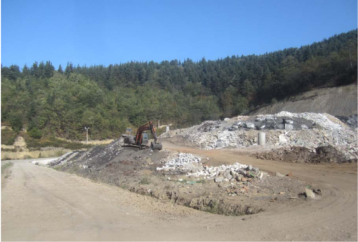
Fotografía nº 8 – Celda de vertido en explotación Fase I y berma Oeste (31/10/2014)
