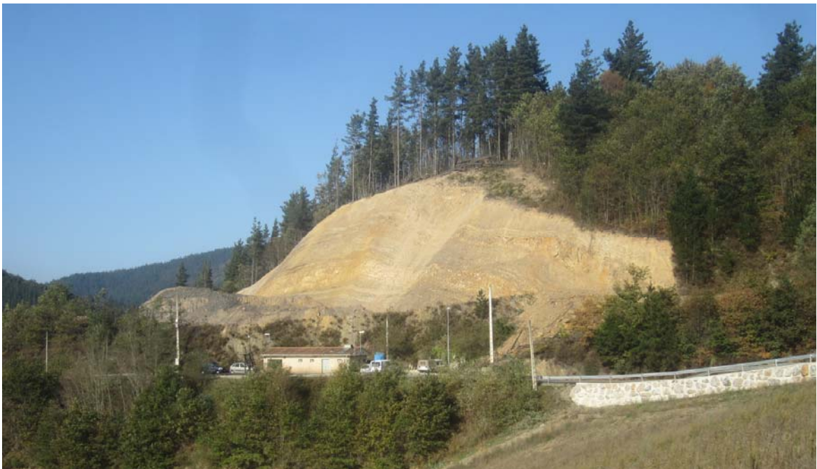
Fotografía nº 13 – Estado Actual del banco de tierras (31/10/2014)
