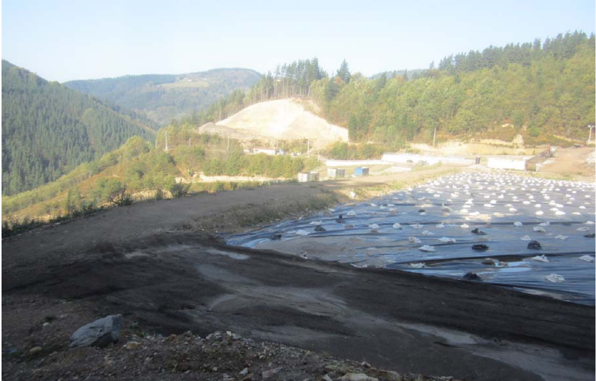
Fotografía nº 4 – Estado de la berma frontal de la Fase II (31/10/2014)
