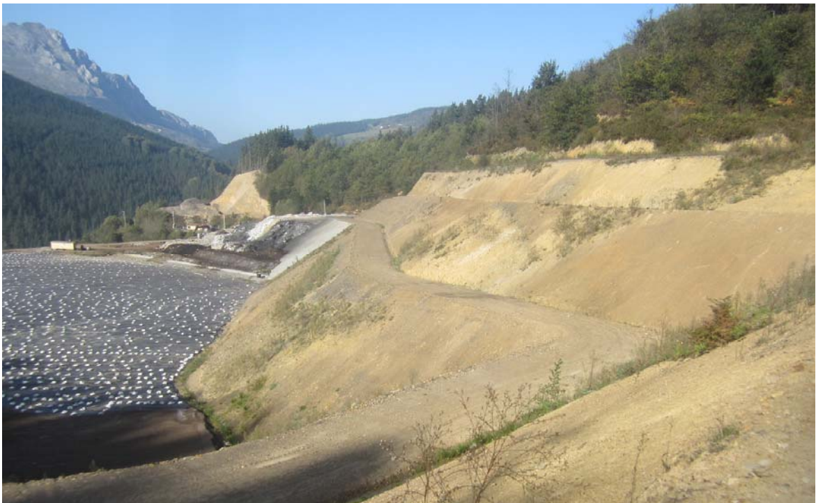
Fotografía nº 2 – Estado del talud de la celda de vertido Fase II proyectada (31/10/2014)
