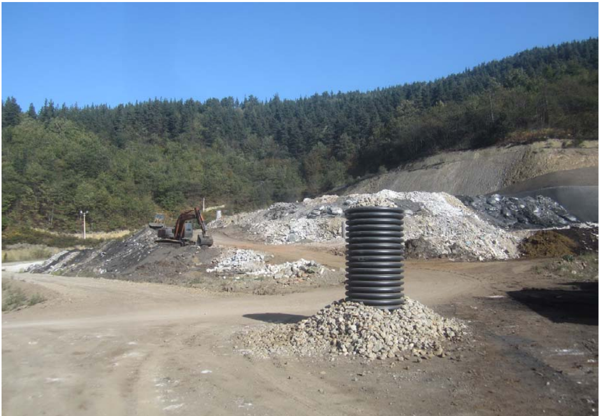
Fotografía nº 7 – Acceso actual a la celda en explotación – Fase I (31/10/2014)
