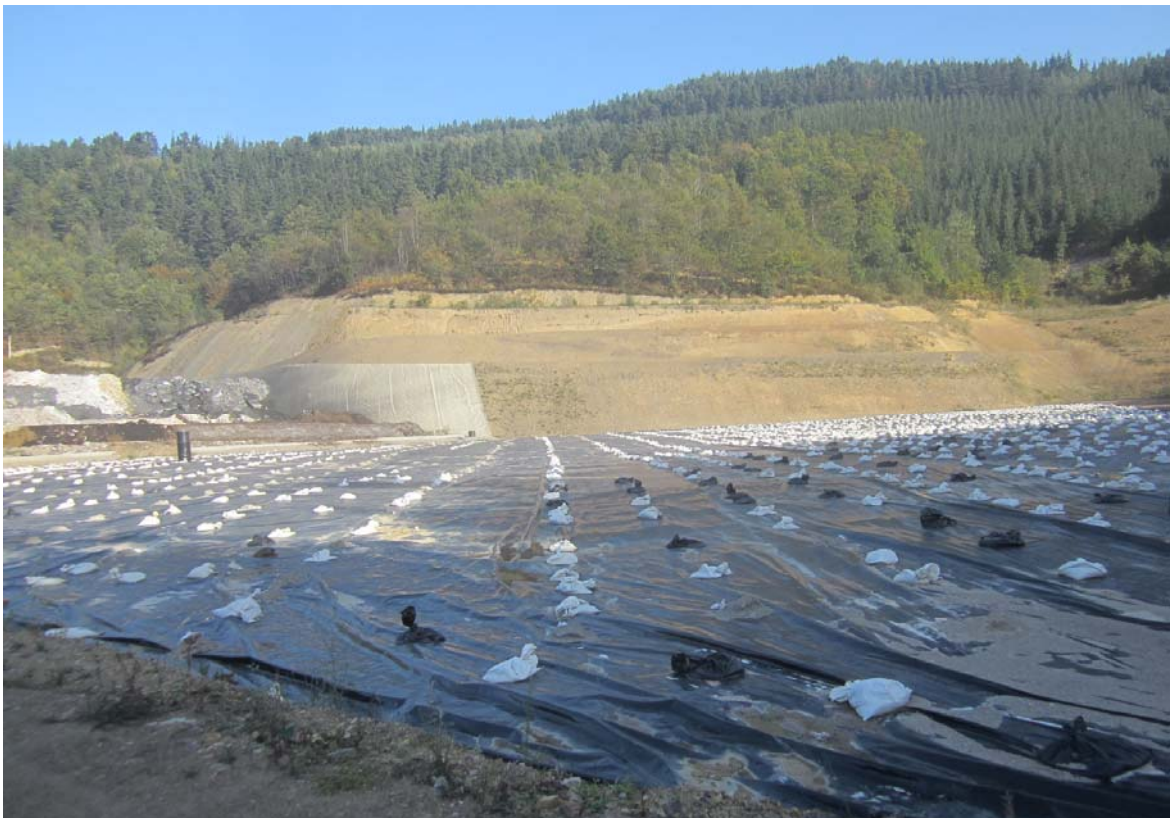
Fotografía nº 5 – Plataforma de la celda de vertido Fase II a ejecutar (31/10/2014)
