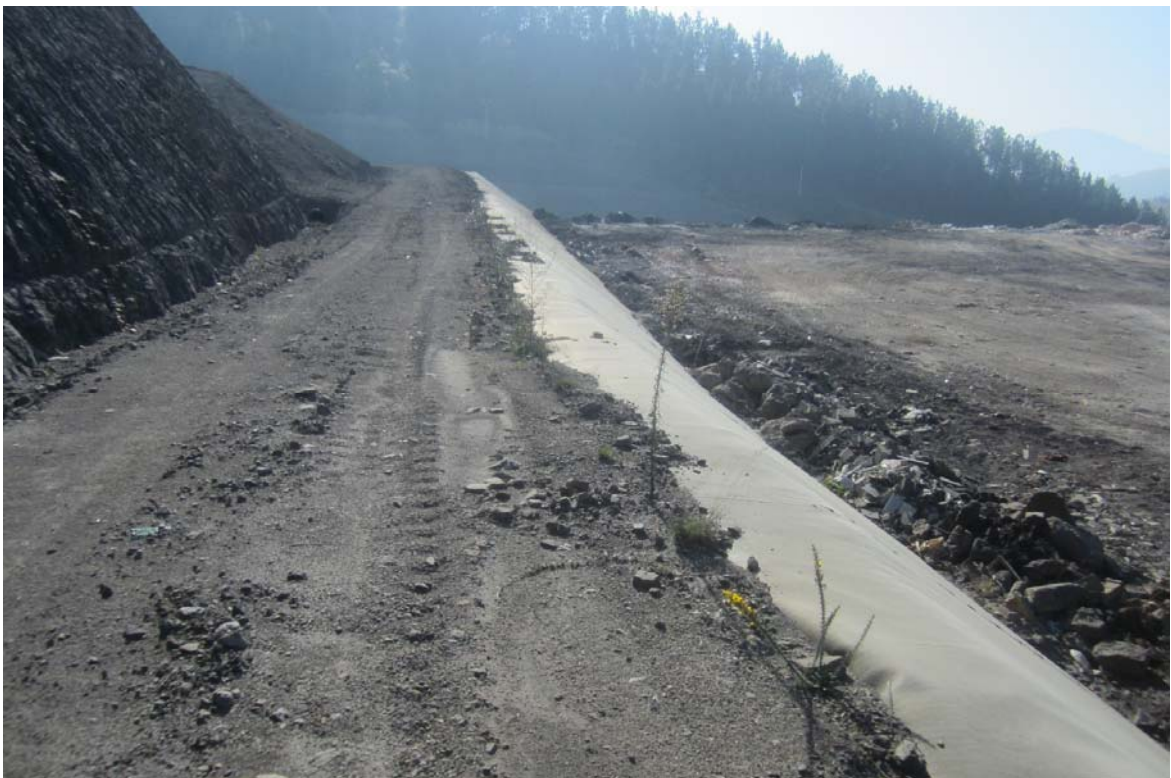
Fotografía nº 11 – Berma Este de la celda de vertido Fase I en explotación (31/10/2014)
