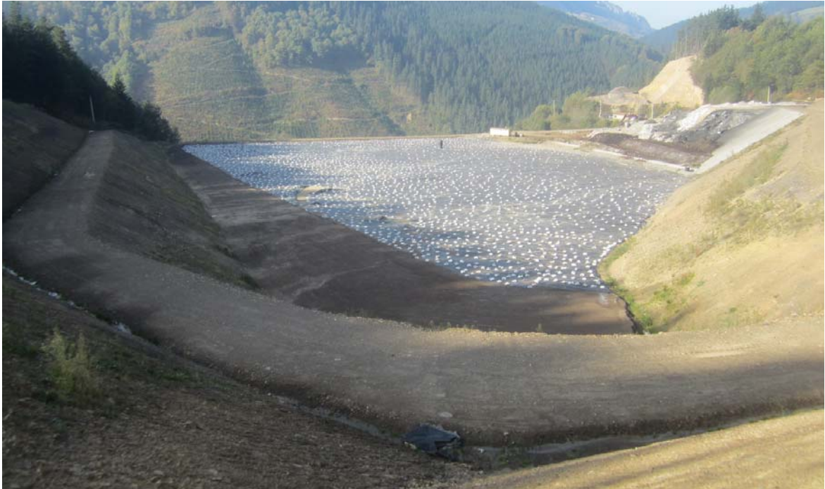
Fotografía nº 1 – Estado de la celda de vertido Fase II proyectada (31/10/2014)
