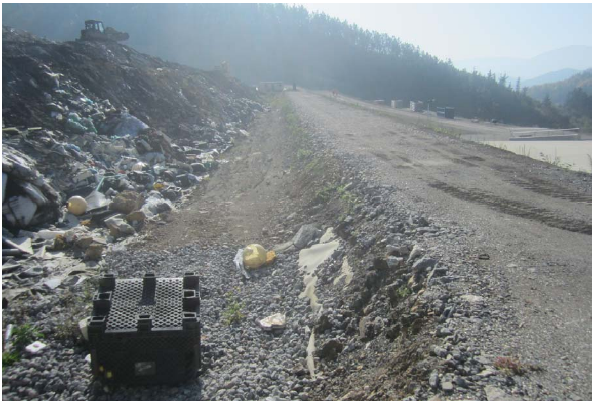
Fotografía nº 9 – Berma Oeste de la celda de vertido Fase I en explotación (31/10/2014)
