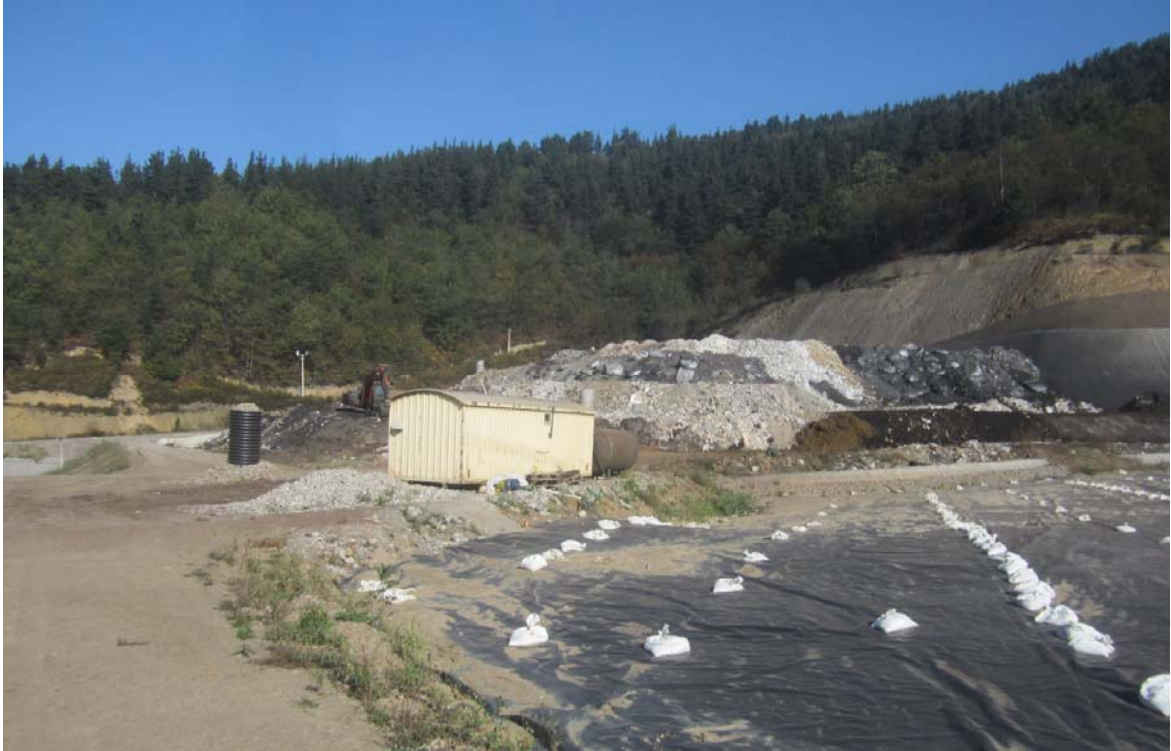
Fotografía nº 6 – Estado de las instalaciones a trasladar (31/10/2014)
